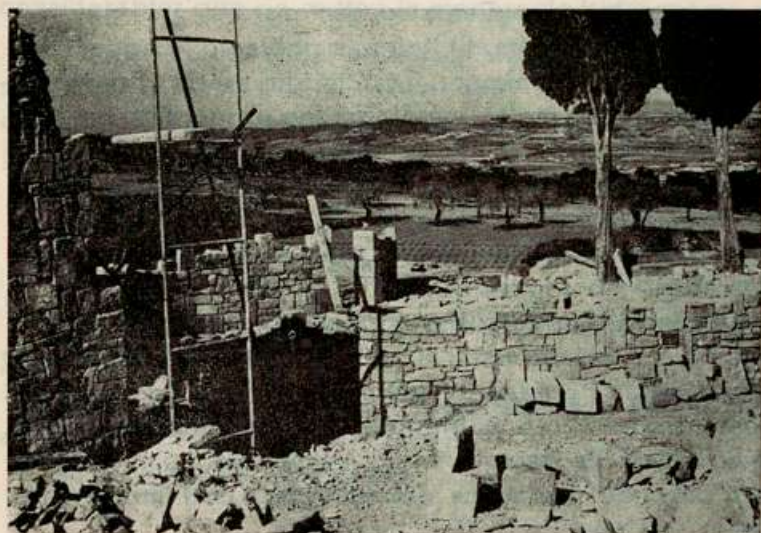
L'Ermita en construcció
