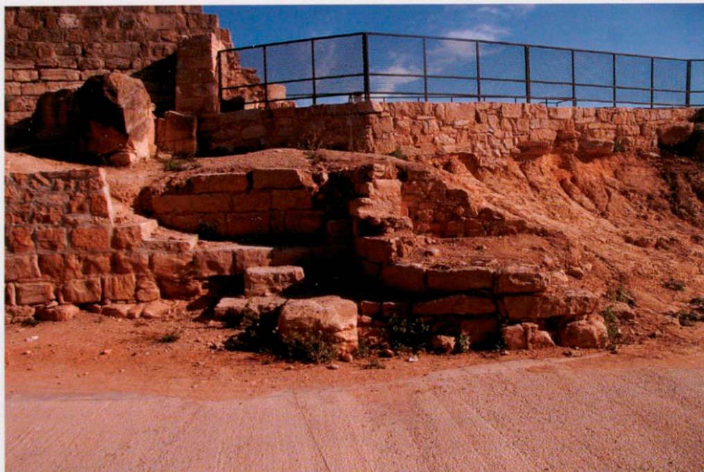
Basament de la bestorre del costat oest del castell, sector 2000.
