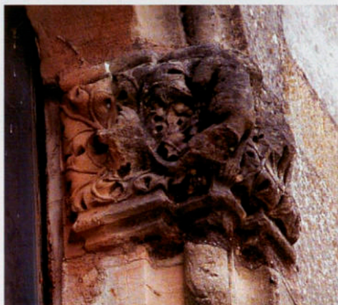
Vista general i del capítell del costat dret de la finestra ubicada a la façana nord del santuari del Tallat.
