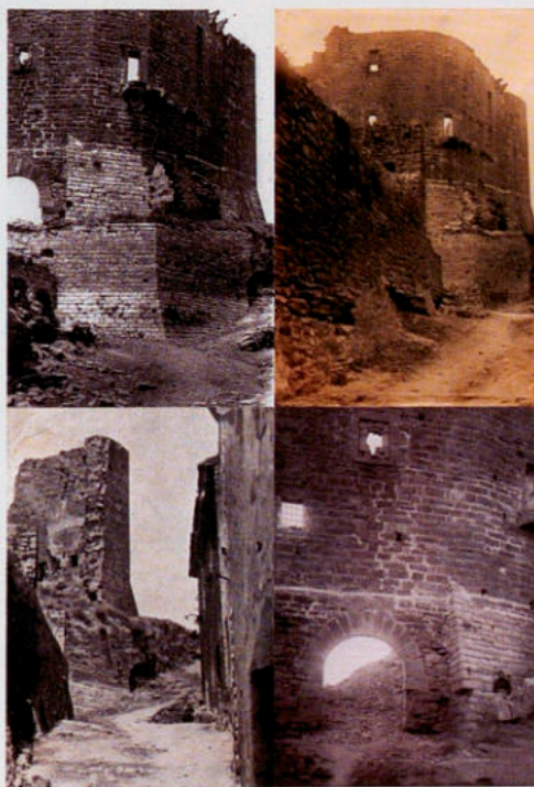
Diferents fotografies de la façana principal del castell a principis del segle xx, abans i després dels treballs d'aterrament.
