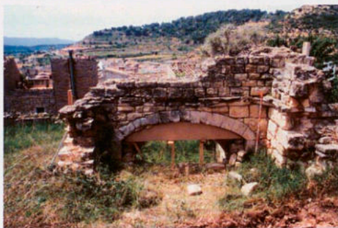
Porta del castell durant els primers treballs arqueològics i d'apuntament de l'arc, any 1998.
