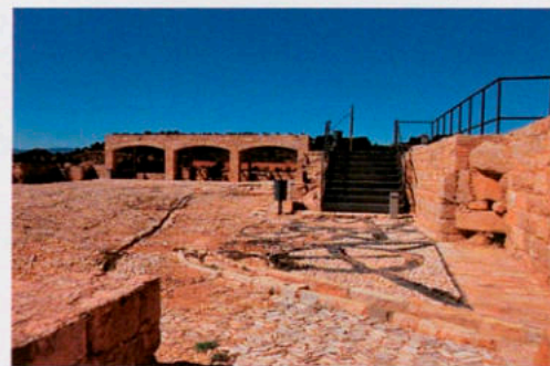
Paviment de palets de l'escala del castell després de les obres de restauració.
