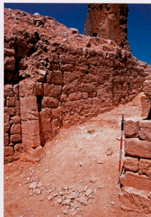
Detall de la porta de tancament de la rampa d'accés al pati durant els treballs de 1998.
