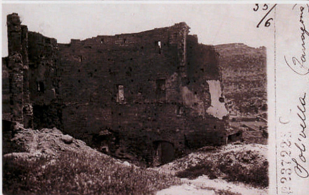
Dues imatges del castell a principis del segle xx, durant el procés d'enderrocament. La primera és una fotografia estereoscòpica on es veuen tres dels murs encara dempeus, i a la segona veiem que la porta encara és dreta.
