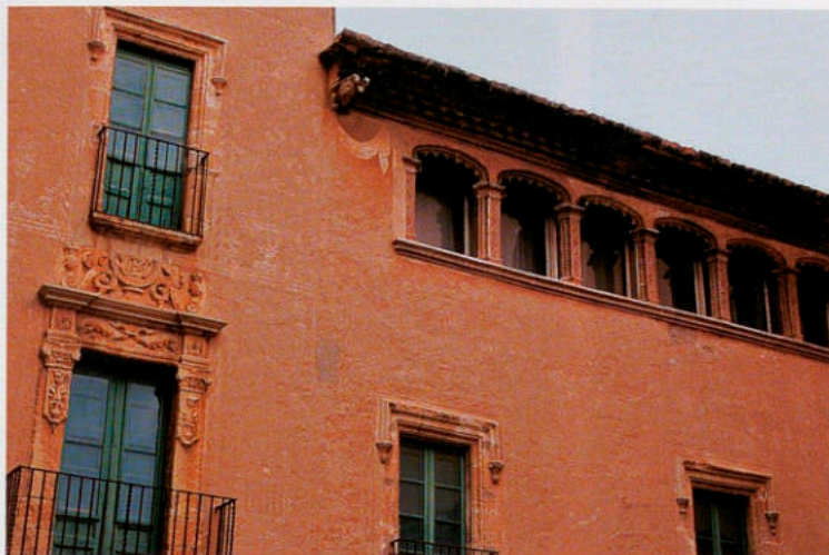
Galeria de la casa del Portal del Pardo, al Vendrell.
