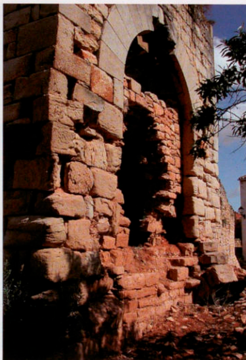
Torre-porta durant els treballs de 2008. Al peu es veu l'arrencada del pont d'entrada.
