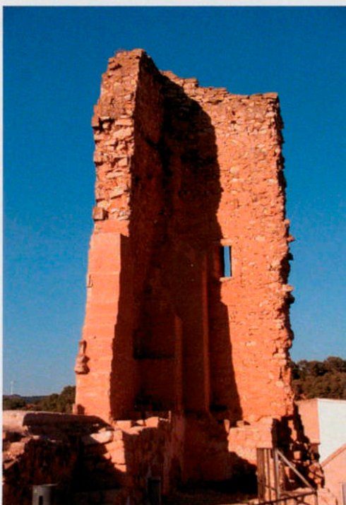
Cantonada nord del castell. A la part interior de la torre es veuen, ja consolidats, els murs de tàpia d'una construcció anterior al palau goticorenaixentista.
