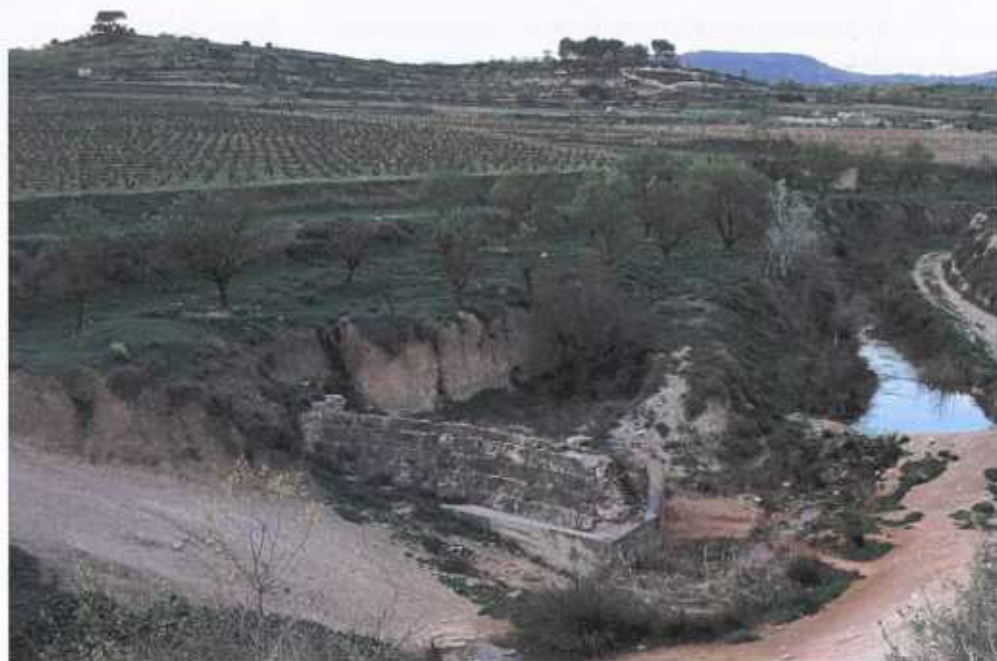
Preses romana del barranc de la Salada. Al terme municipal de Sarral, al bell mig del barranc de la Salada, es localitza una presa de derivació o assut, construïda en època romana, la finalitat de la qual és elevar el nivell de l'aigua per desviar-la cap a un canal. Vista del parament d'opus quadratum i de l'únic estrep que es conserva. (Fotografia de M. Sardà)
