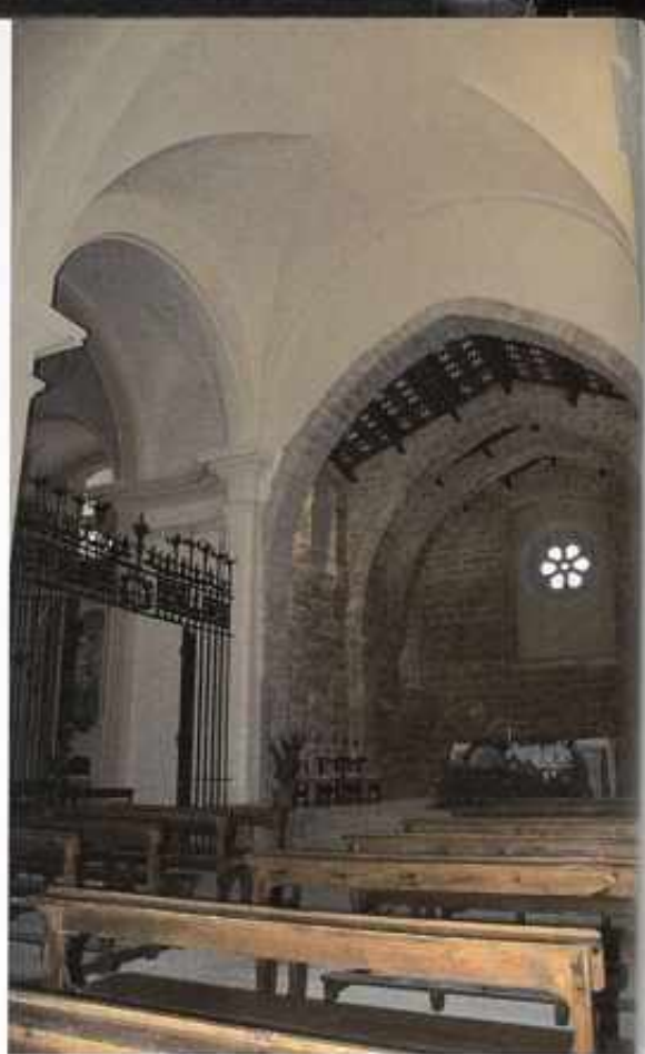
La Guàrdia dels Prats. Església de Sant Jaume. En època barroca se substituï la coberta de fusta per una volta de canó amb llunetes i es treballà el presbiteri a l'oest. (JFS)
