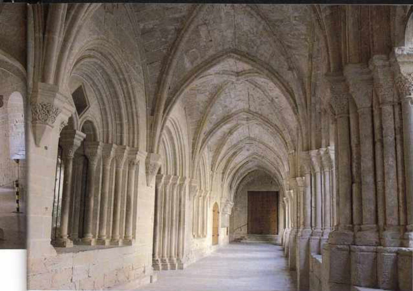
Poblet. Claustre. A Poblet el claustre està situat al costat nord, localització que contravé la disposició habitual del Cister. La major part es va bastir el segle XIII. (JFS)
