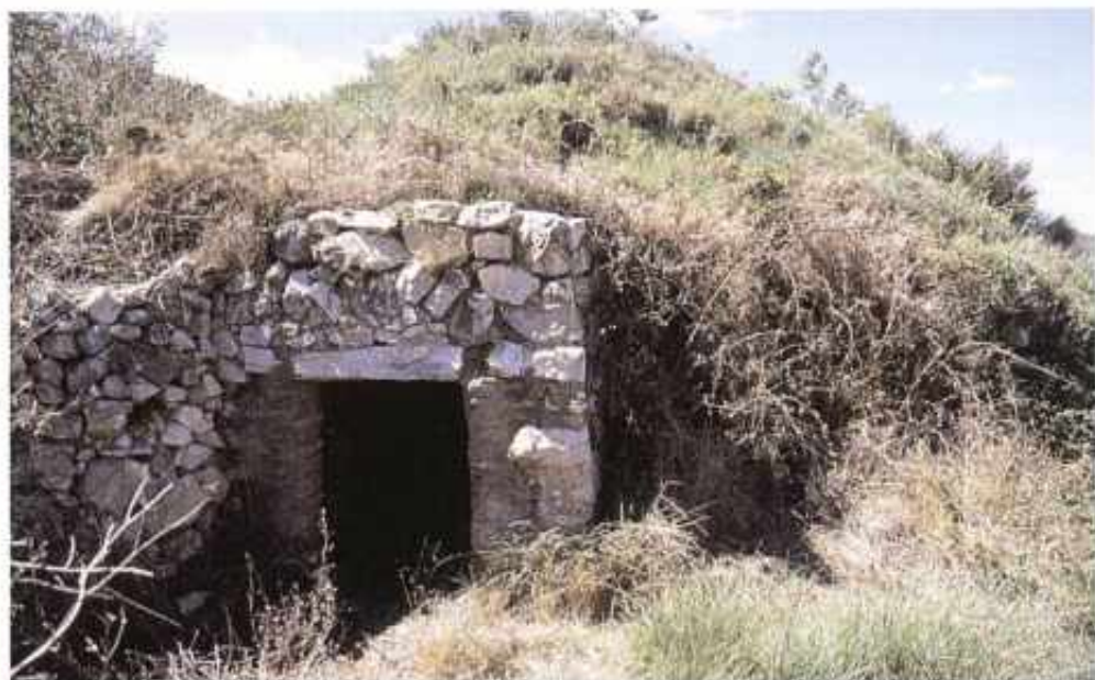
Vilaverd. Pou de gel. Aquest pou, del qual només veiem l'entrada situada a la part superior, té planta circular d'uns 10 m de diàmetre i altres tants d'altura. (MMG)
