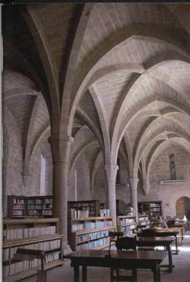
Poblet. Biblioteca. Ocupa les que abans foren sala de monjos i novícia. És una típica construcció del XIII de dues naus amb coberta de creueria. A finals del segle XVII Pere Antoni d'Aragó, seguint les perijades del rei Pere el Cerimoniós, donà la seva important biblioteca al monestir. (JFS)
