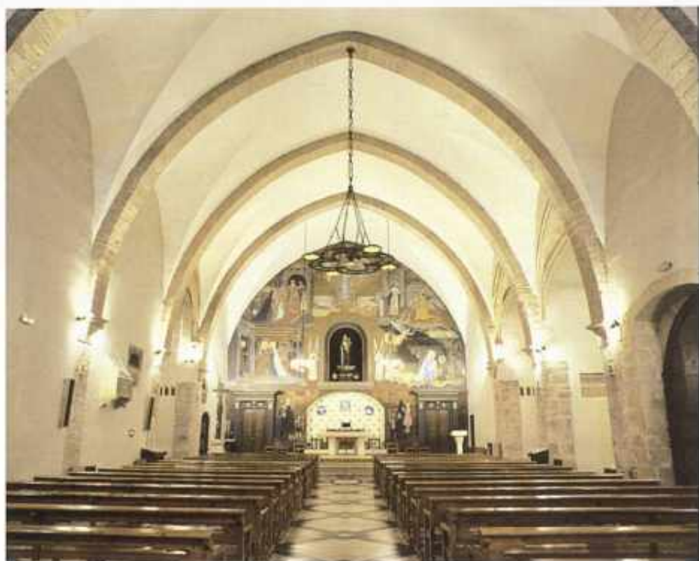
Montblanc. Santuari de la Serra. Els arcs diafragma de la coberta són ben visibles, però el primitiu teginat fou destruït en època moderna per construir l'actual volta de rajola de pla, (JRF)
