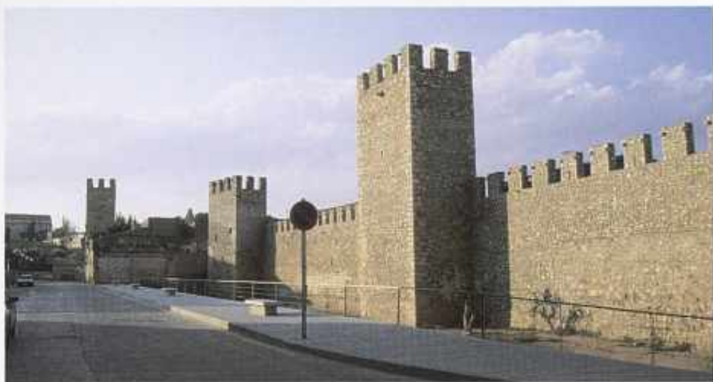
Montblanc. Vista parcial de la muralla presumiblement construïda sota la direcció de fra Guillem de Guimerà. (JFS)
