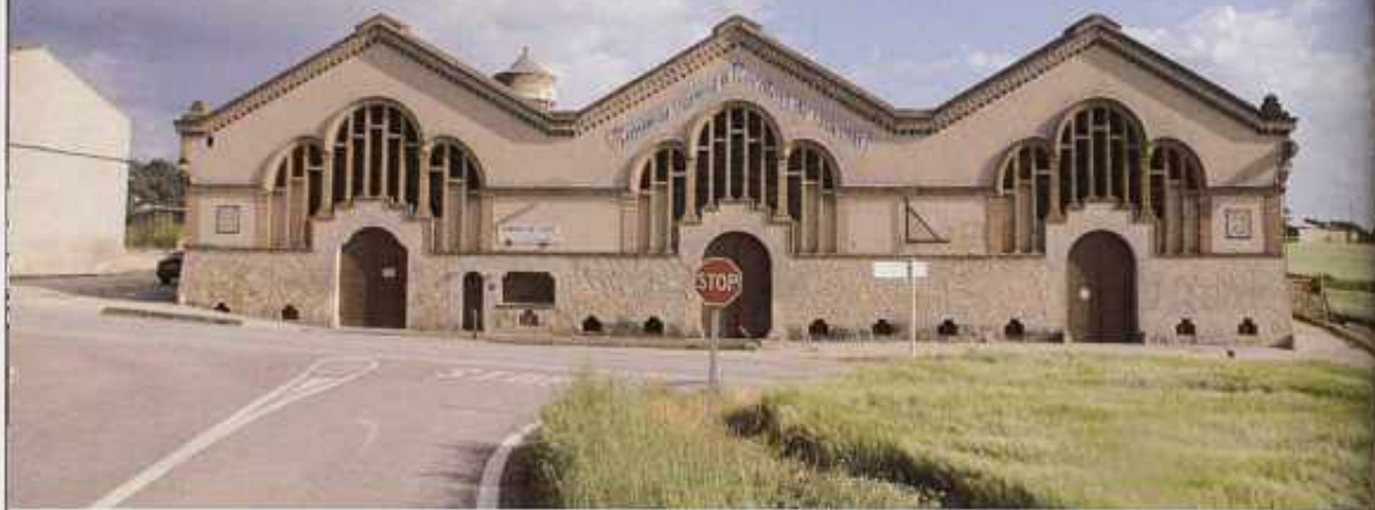
Rocafort de Queralt. Façana del celler de Cèsar Martinell. (JFS)
