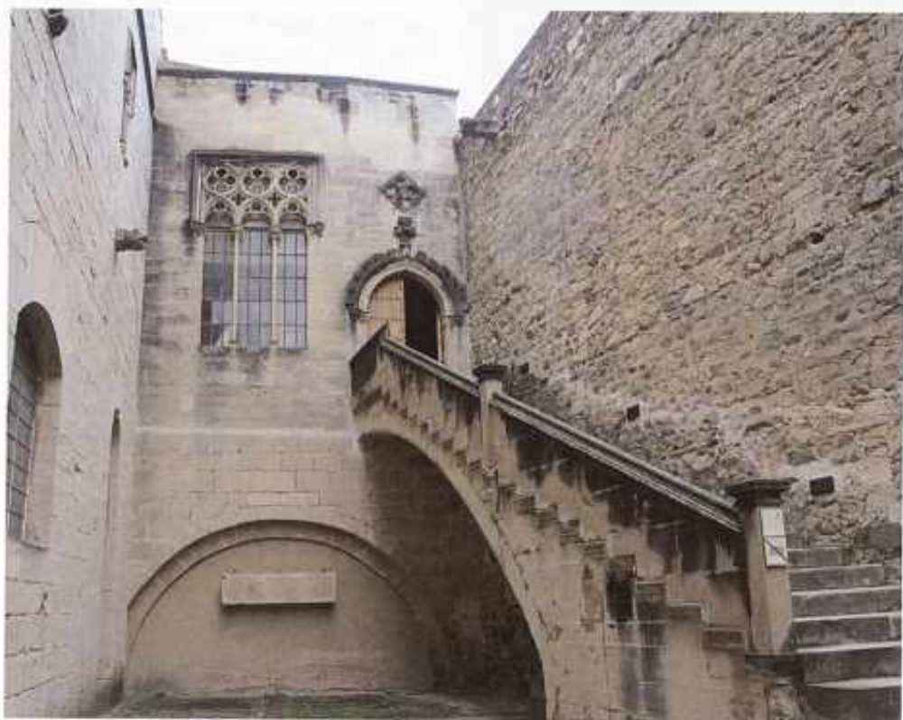
Poblet. Palau del rei Martí. L'edifici presenta l'estructura típica del palau català; des del pati, una elegant escala d'arc rampant dona accés a la planta noble. (JFS)
