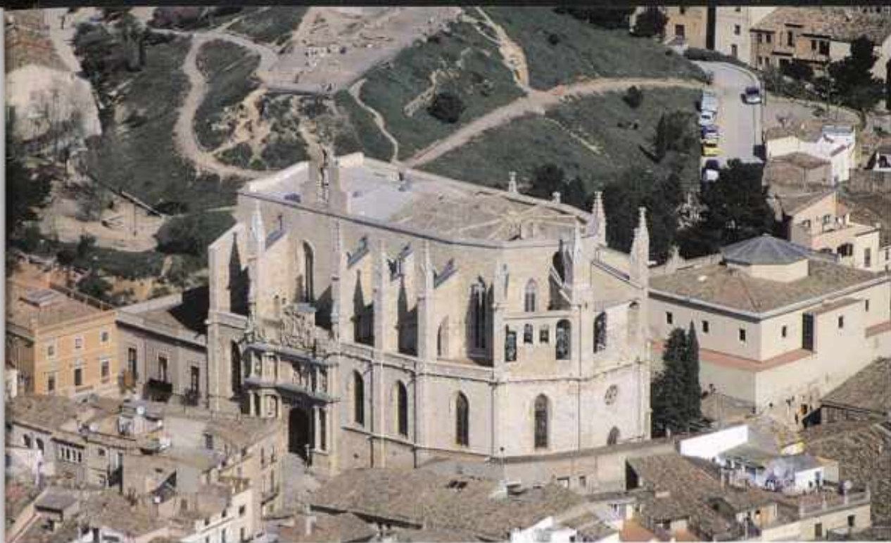
Montblanc. Església de Santa Maria. Vista aèria on es pot apreciar els contraforts de l'absis, envoltats per un mur que tanca les capelles. (FAC)
