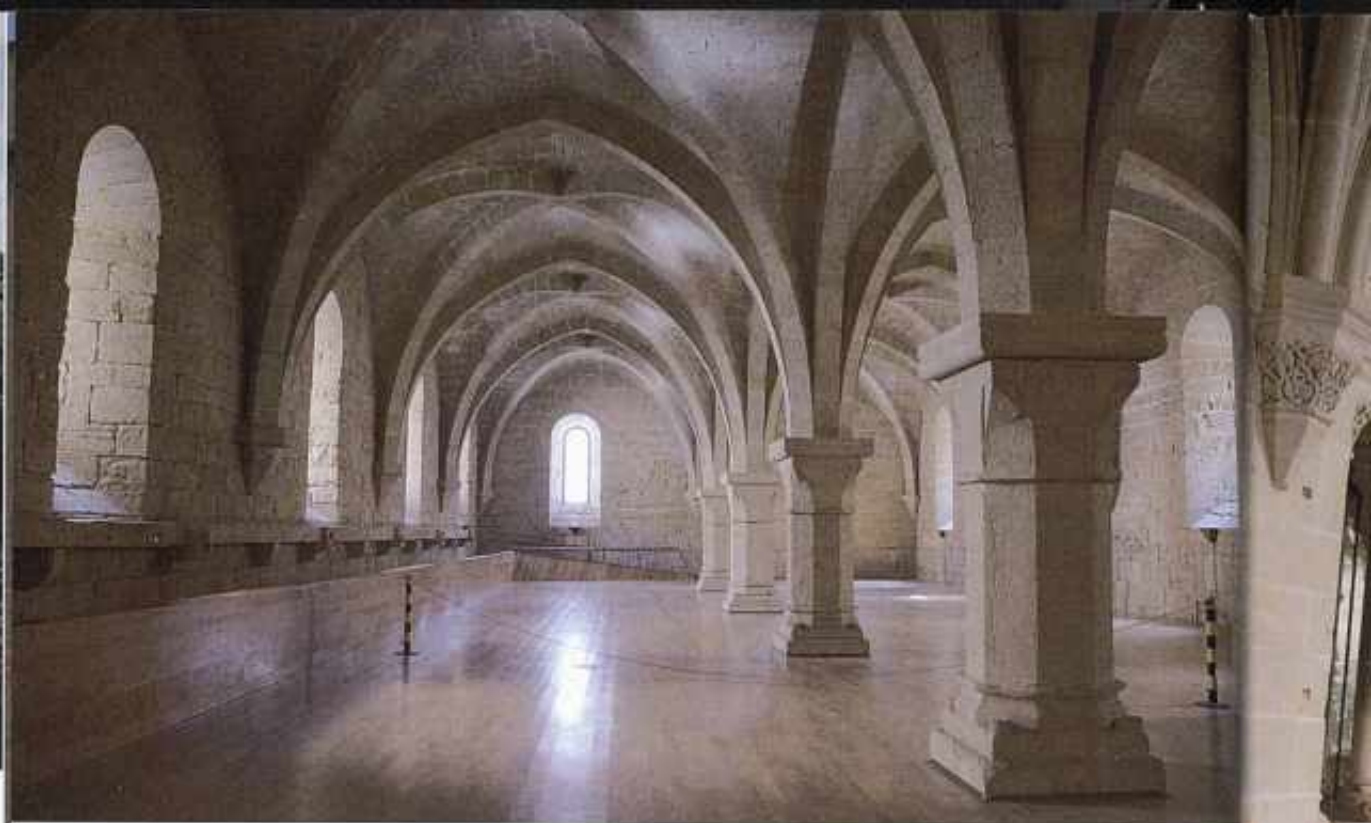
Poblet, Celler. És l'antic refector de conversos del segle XIII, reformat un segle més tard per habilitar-lo com a celler. En la reforma s'excavà el sòl uns metres. La restauració de 1996 retornà a la sala el seu nivell original mitjançant un empostissat de fusta. (JFS)
